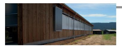
Le filet latéral de ventilation représente environ 1/3 de la surface. Ce filet entouré de bois s'assimile à un détail constructif Vue du bâtiment dans toute sa longueur avec les découpes de hauteur de bardage bois selon les espaces construits
