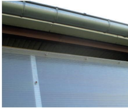
Une lame d'air bien protégée sous le débord de toit. Un volet de ventilation simple dont les charnières se fixent directement sur l'ossature support du bardage polycarbonate et bois.
