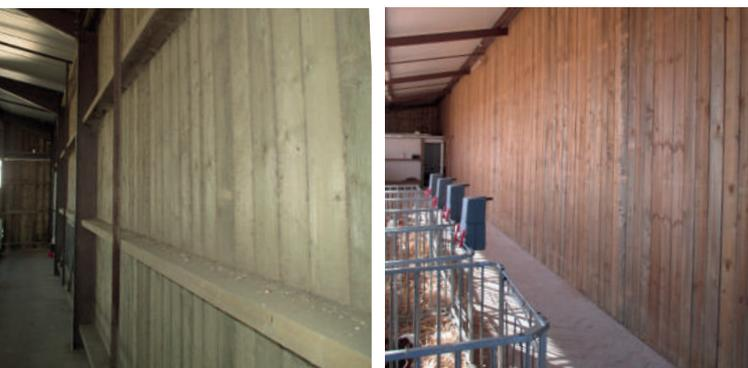
Vue de la paroi intérieure entre partie box et auvent des niches. Le bardage bois très légèrement ajouré amène une lame d'air aux box. La partie auvent réchauffe cet air. Le bardage protégé descend jusqu'au béton. Les ossatures sont bien rigidifiées par une cornière médiane.
