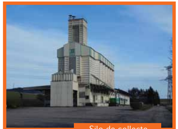
Silo de collecte
