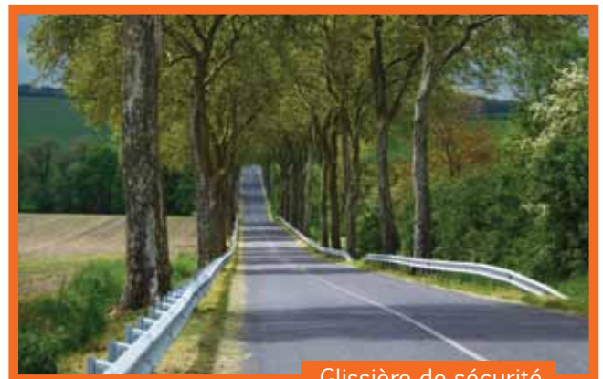
Glissière de sécurité
